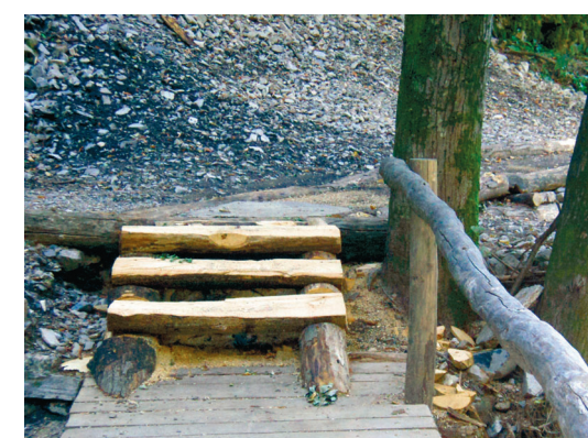
Laddove è necessario, si procede alla costruzione di gradini o ponti.
